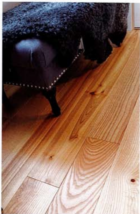
Golven är gjorda av massivt trä, antingen som brädgolv eller som parkettgolv av ask.
