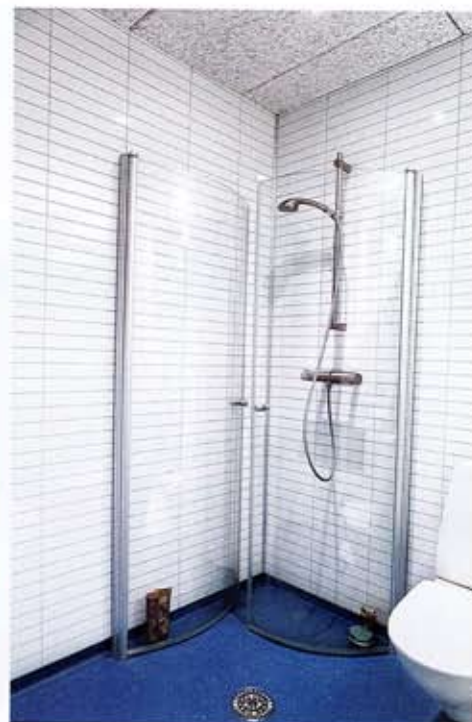
Badrummen har väggar av plywood med melaminyta och golv av miljövänlig plast.
